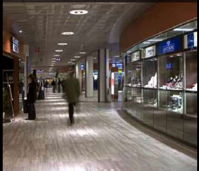
Kauppakeskus Trio, Lahti Urakoinnin asennustyö: sisälasisseinät, lasikaiteet jne.
